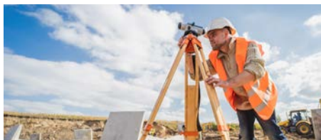
Topograf în construcții
