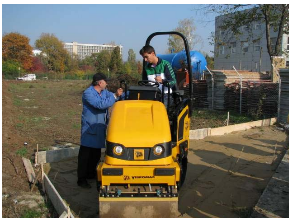
Cilindru vibrocompactor – lucrări practice
