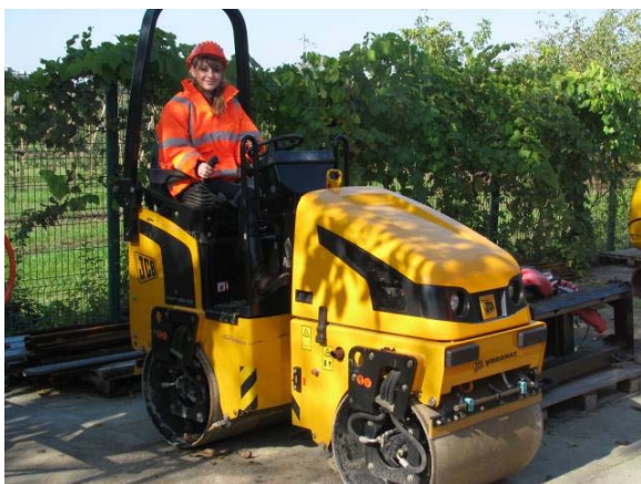
Cilindru vibrocompactor – lucrări practice
