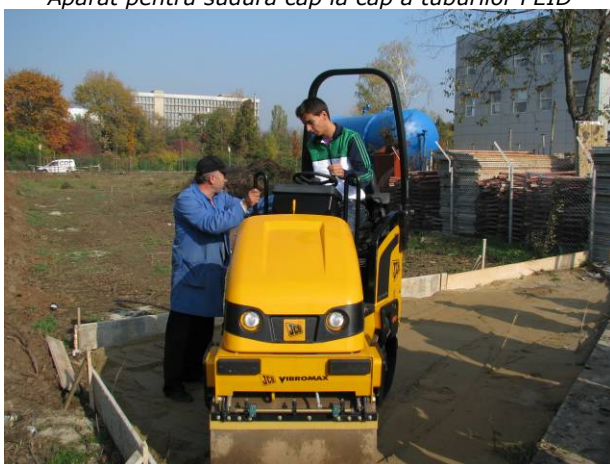
Cilindru vibrocompactor – lucrări practice
