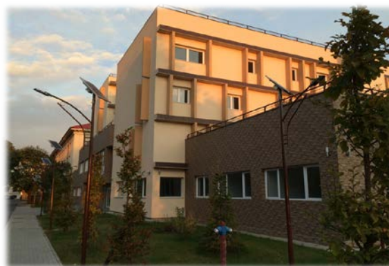
Clădirea Centrului de cercetare HORTINVEST (2014)
