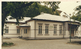
Logement du directeur, construit en 1925–1927
