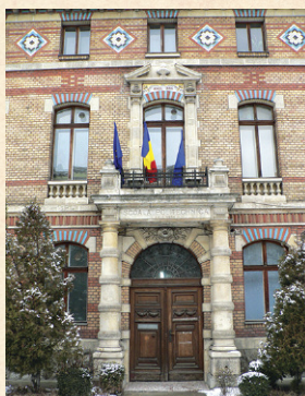
Institut Polytechnique, bâtiment Polizu
