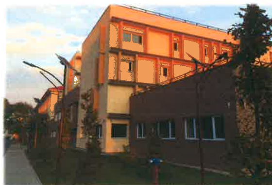
Clădirea Centrului de cercetare HORTINVEST (2014)
